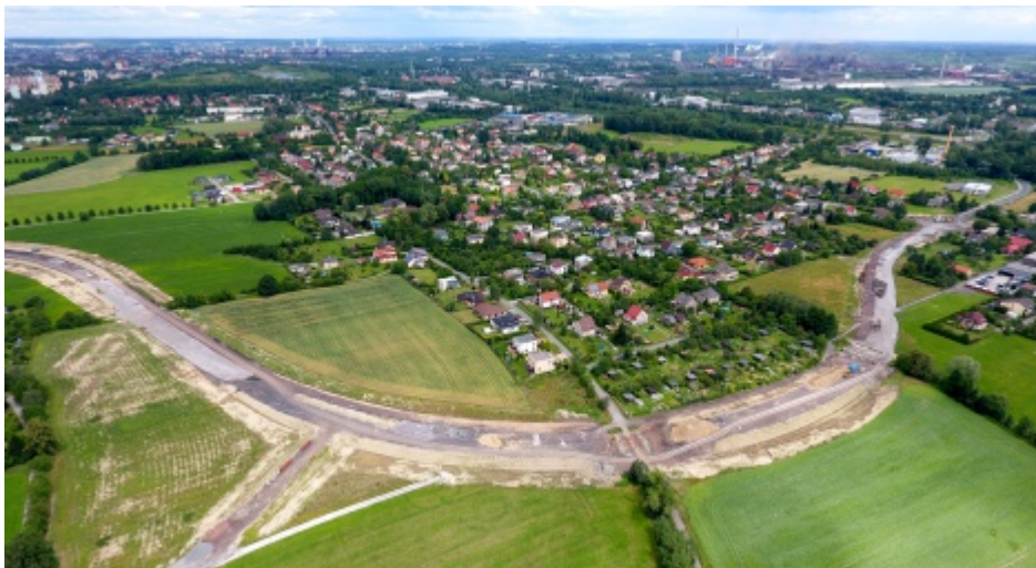
Stavba silnice 1.7.2018, první den uzavírky křižovatky Mostní s Paskovskou
