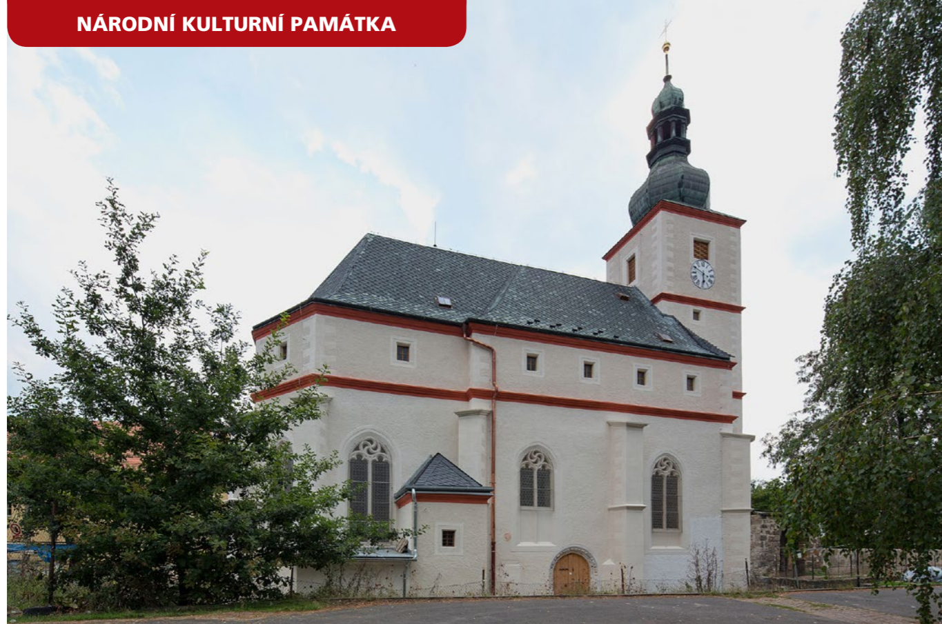
Kostel sv. Floriána v Krásném Březně v roce 2016, snímek po rekonstrukci
