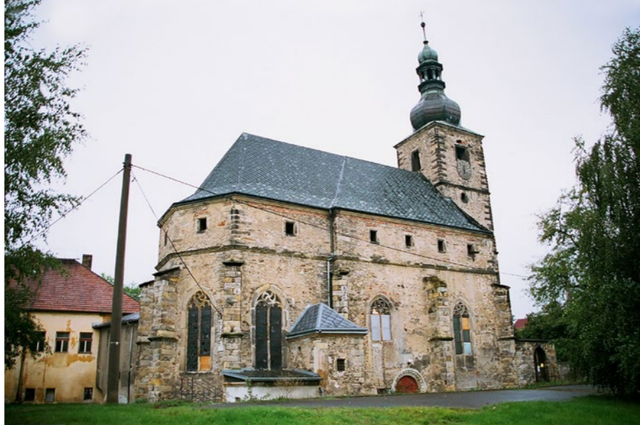
Kostel sv. Floriána v Krásném Březně v roce 2006, snímek před rekonstrukcí
