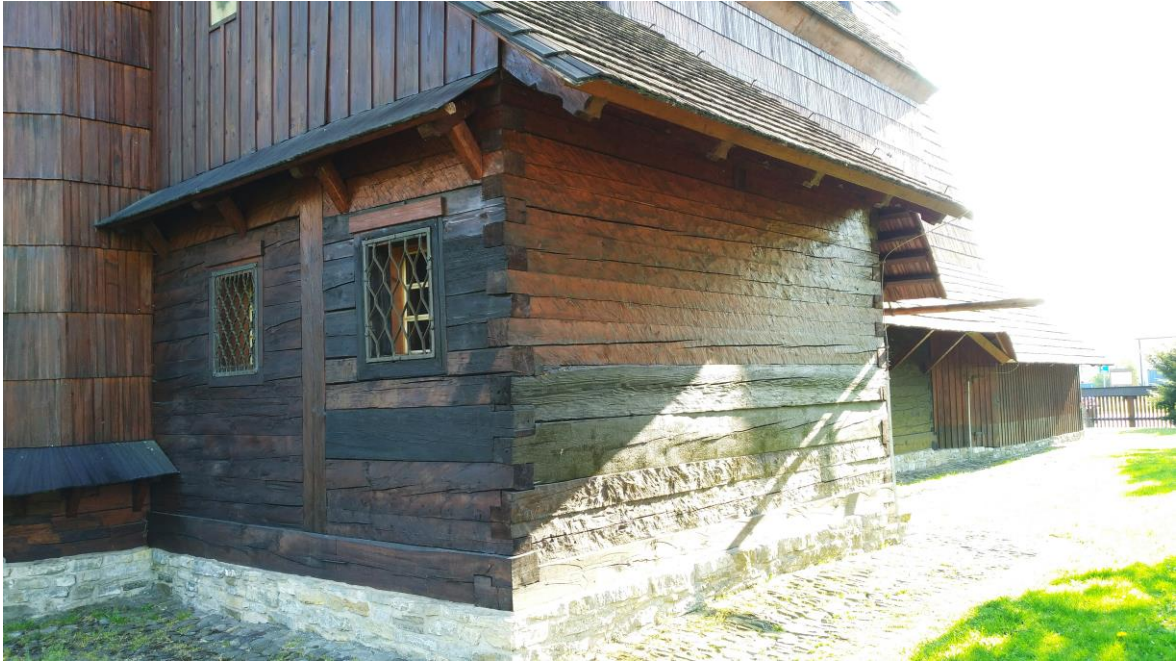
Pohled na sakristii hrabovského dřevěného kostela sv. Kateřiny Alexandrijské se zakomponovanými původními trámy vyhořelého kostela, 7. května 2020
