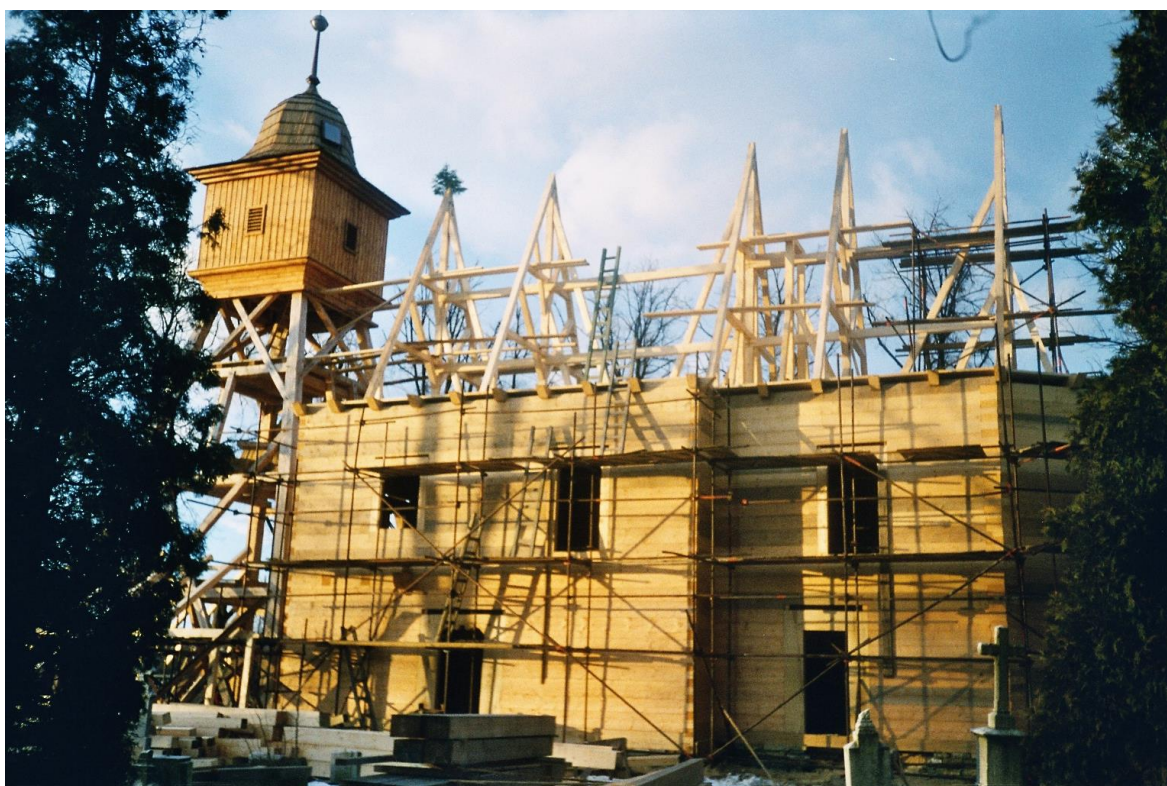
Obnova hrabovského dřevěného kostela od jihu, 2004
