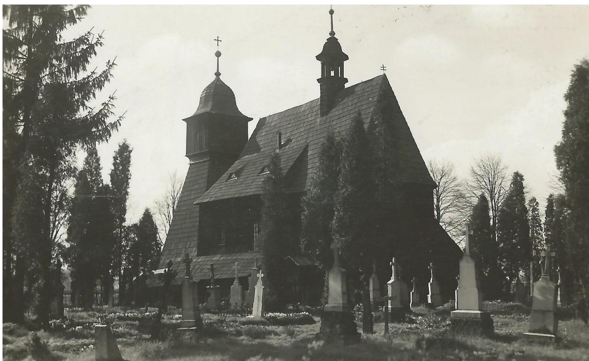
Pohled na hrabovský kostel sv. Kateřiny od jihovýchodu, sedmdesátá léta 20. století
