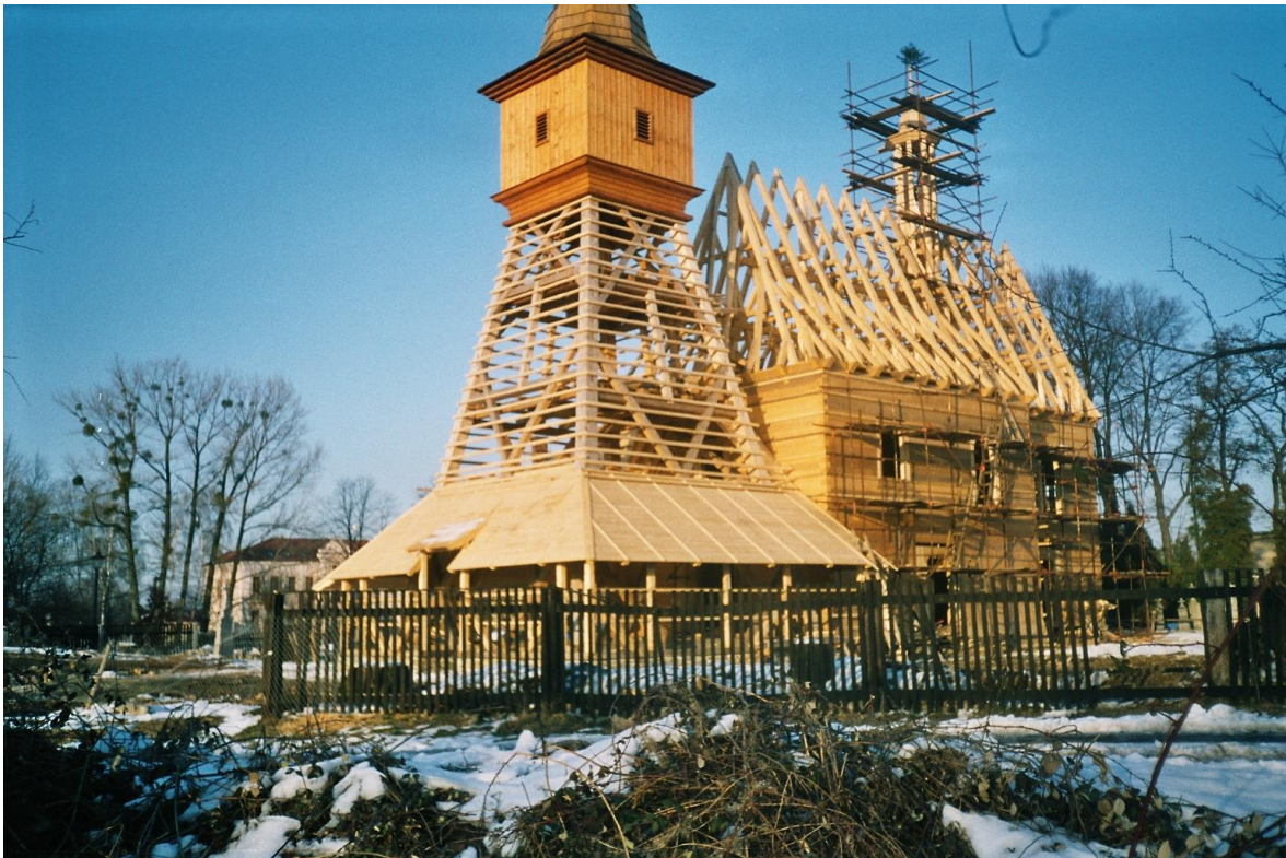
Obnova hrabovského dřevěného kostela od jihu, 2004
